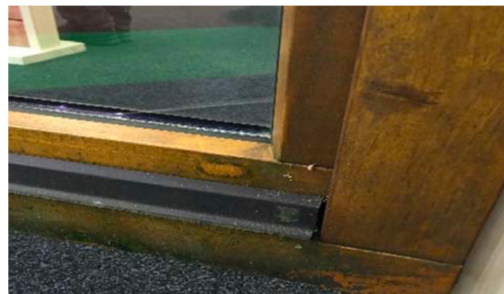
Geen zichtbare coating degradatie
